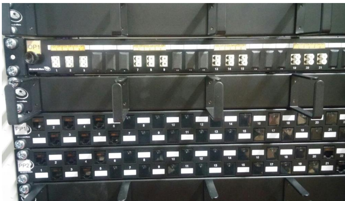
Slika 10. Primjer označavanja razdjelnika i panela
