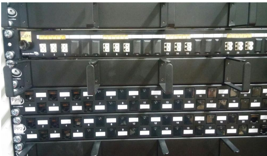
Slika 10. Primjer označavanja razdjelnika i panela
